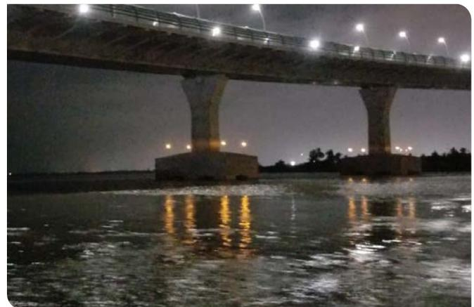
*Dos pilares del puente presentan linternas marinas SL-70 de Sealite y flash sincronizado debajo del puente Pumarejo.*
